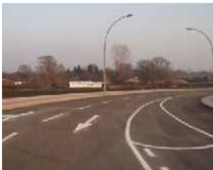
Blick von Anschlussstelle A 113 in Richtung Untersuchungsbereich 1
