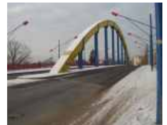
Süd-Ostalleebrücke im Untersuchungsbereich 2
