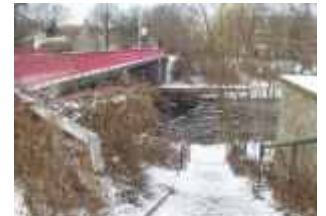
Britzer Allee Brücke im Untersuchungsgebiet 2
